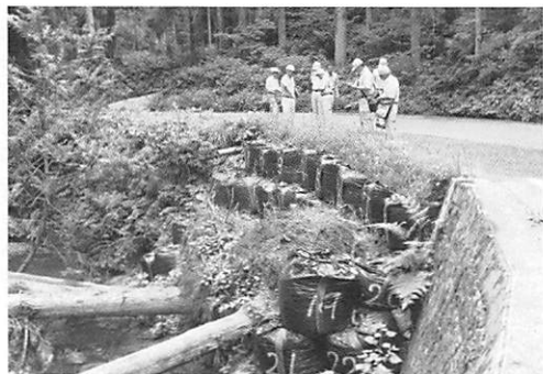
▲林道護摩堂線災害復旧現地調査
