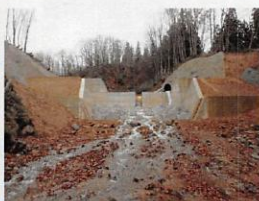
整備中の市ノ沢第2号砂防堰堤
